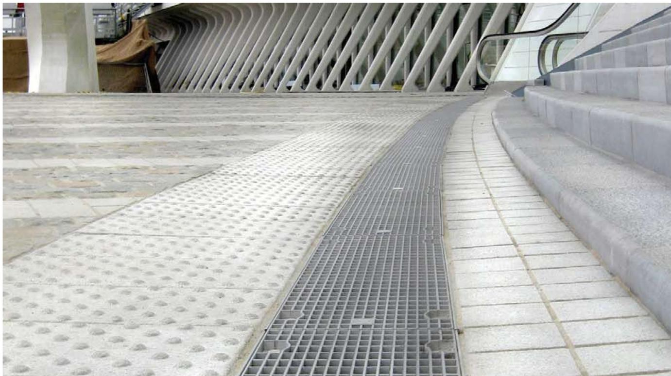
BIRCOprofil verbindet verschiedene Anforderungen. Einsetzbar bei geringen Aufbauhöhen gewährleistet die Stahlrinne optimale Entwässerungsleistungen bei zuverlässiger Verkehrssicherheit. Sie nimmt Schleppwasser auf und fungiert als Entlastungs- und Verdunstungsrinne.
