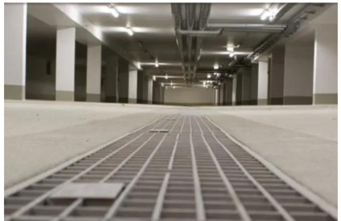
BIRCOprofil in einer Tiefgarage: Staunässe durch Schnee und Schleppwasser werden abgeleitet.
