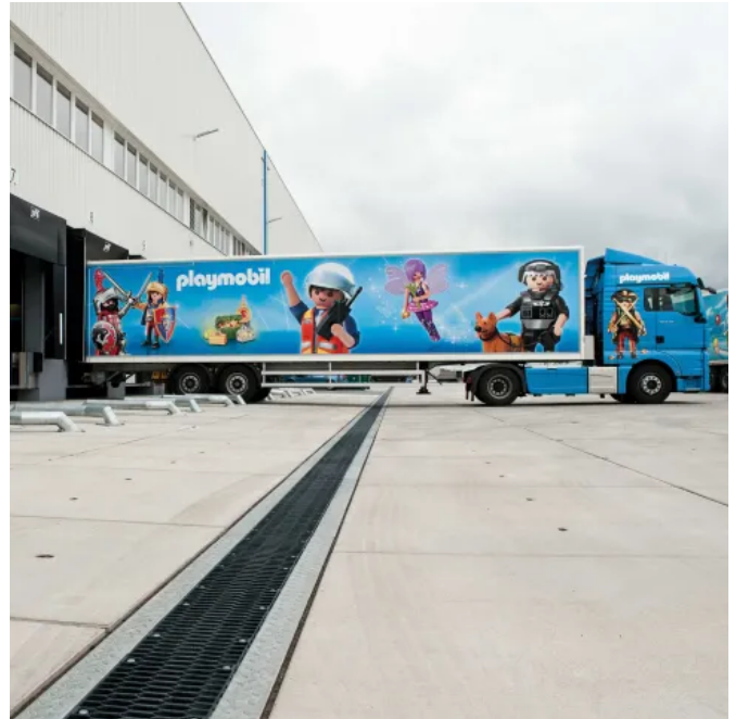
Entwässerungslösung bei Wareneingänge sowie -ausgänge. BIRCOmassiv mit Wabenabdeckung.
