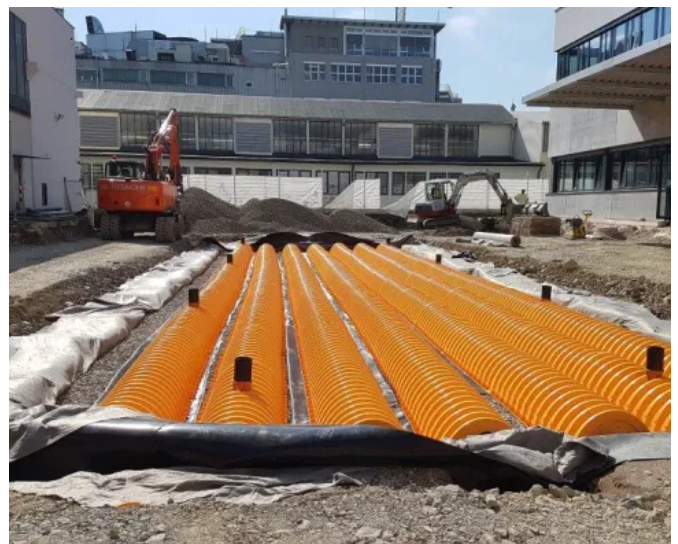
Retentionssystem mit gedrosseltem Ablauf
