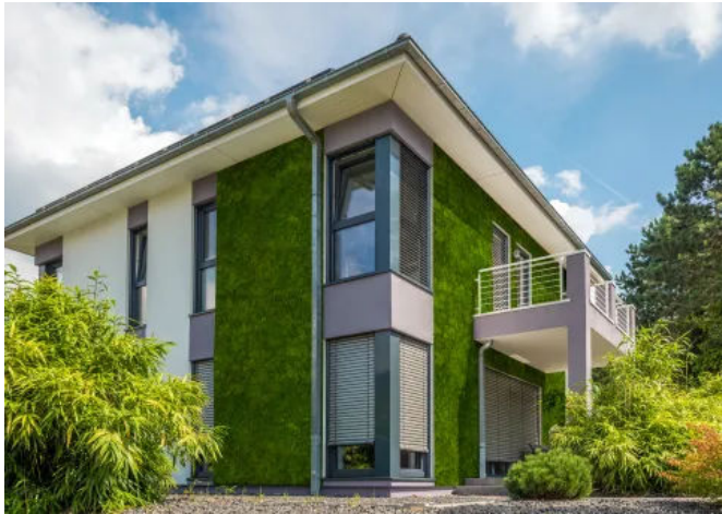
Moosfassaden - Fassadenbegrünungen (© Alexander & Theresia Schulz)
