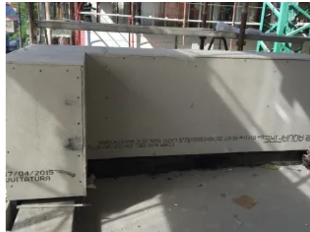
Aquafire als feuerbeständige und feuchteresistente Bekleidung im Fassadenbau.
