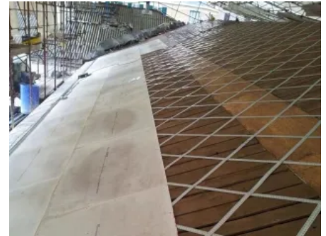
Feuchtebeständige Brandschutzbekleidung bei einer Holz-Zwischendecke mit Unterkonstruktion
