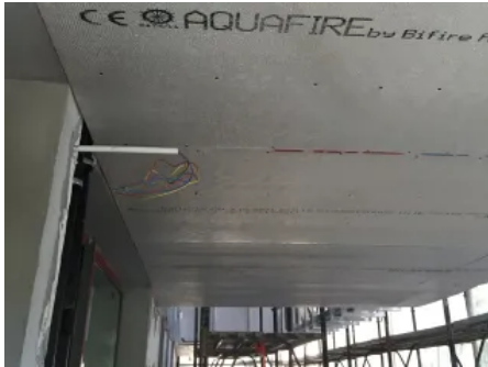
Nachrüstungen und Sanierungen vorhandener Decken- und Wandkonstruktionen für hohe Brandschutzanforderungen bis REI 180
