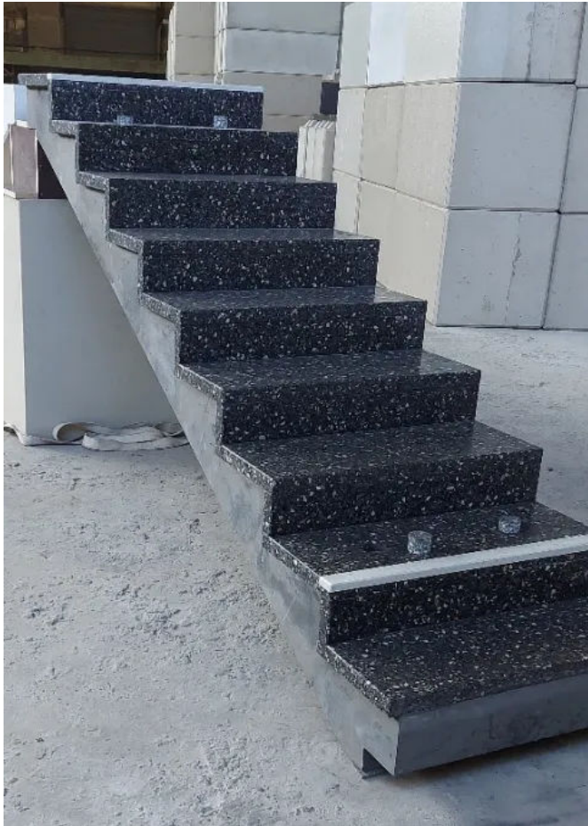
Fertigteiltreppe mit Belagstufen aus Betonwerkstein, feingeschliffen.
