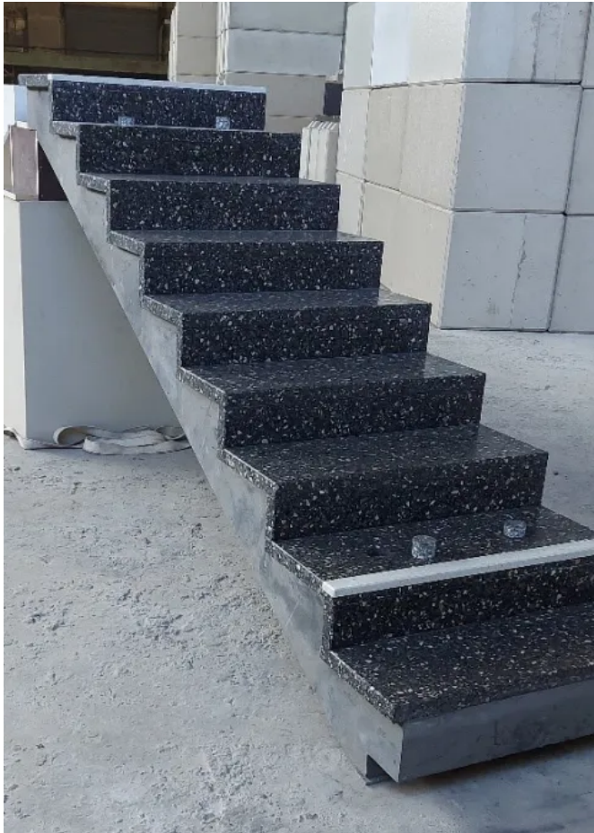
Fertigteiltreppe mit Belagstufen aus Betonwerkstein, feingeschliffen.
