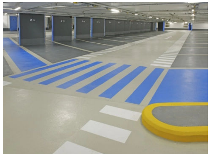
Tiefgarage Markplatz, Waiblingen, DE. Foto: Isabell Munck
