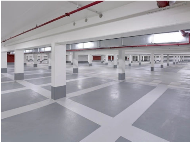
Bodenbeschichtung und Oberflächenschutz, Tiefgarage Platz D'Agen, Dinslaken. Foto: Guido Erbring
