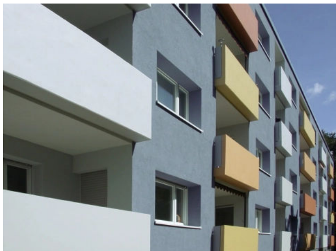
Balkonsanierung und Bodenbeschichtung von Wohnanlagen. Foto: StoCretec
