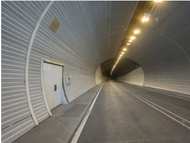
Tunnelbeschichtung mit StoPox TU 100: Tunnel Ursulaberg, Pfullingen, DE. Foto: Foto:Isabell Munck
