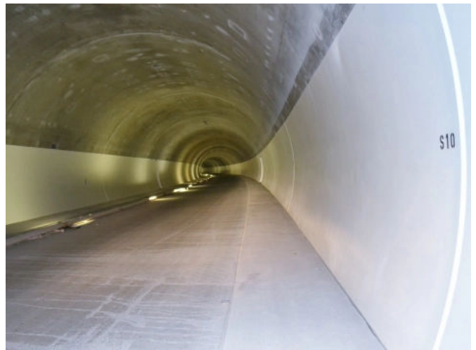
Oberflächenschutz im Tunnel: StoConcrete Protect Tunnel TU 100. Tunnel Hirschhagen, DE. Foto: StoCretec
