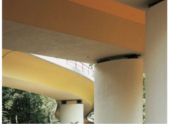
Europaringbrücke Leverkusen, DE. Foto: StoCretec
