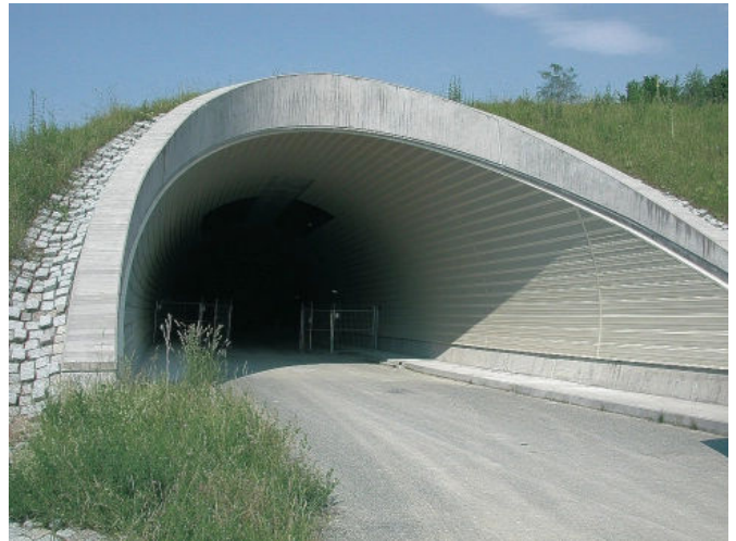
Versiegelungsarbeiten als Spritzwasserschutz: Tunnel Döggingen, DE. Foto: StoCretec
