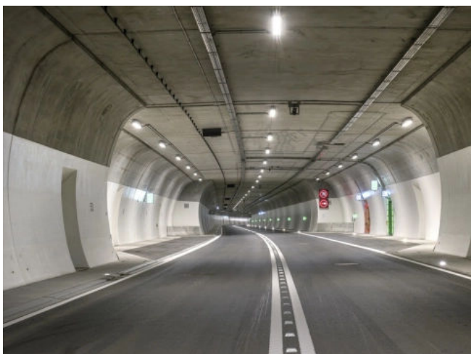
Tunnelbeschichtung StoPox TU 100 für dauerhaften Schutz. Scheibengipfeltunnel, Reutlingen, DE. Foto: Isabell Munck
