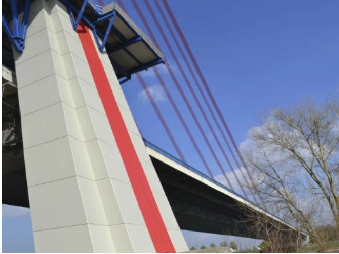
Stahlbeton-Pylon: Schutzbeschichtung gegen Wasser und Schadstoffe, Fleher Brücke, A46, Düsseldorf. Foto: StoCretec
