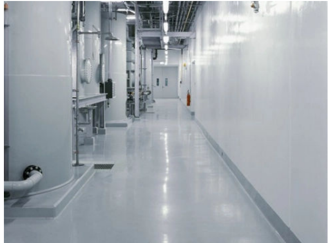
Industriegebäude, DE System: StoFloor Industry Elastic WHG Deck 100 / 110. Foto: Anja Schlamann
