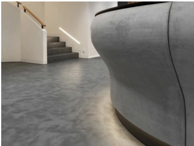
Bodensysteme für Aufenthaltsräume und öffentliche Bereiche: Eingangshalle Augsburg, DE StoFloor Comfort BF 700. Foto: Martin Duckek
