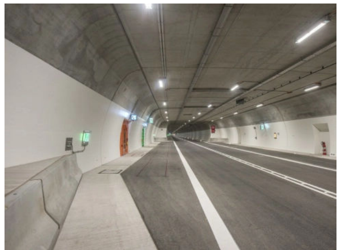
Innovative Tunnelbeschichtungen. Protect Prime Tunnel TU 100. Foto: Foto: Isabell Munck
