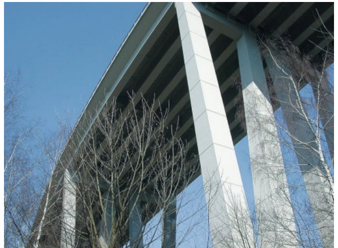
Brückenverstärkung mit CFK-Lamellen. Sulzbachtalbrücke, Friedrichsthal, DE. Foto: StoCretec
