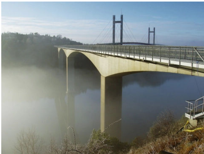
Tragwerksverstärkung mit Sto S&P FRP System, Källösund, Göteborg, SWE. Foto: StoCretec
