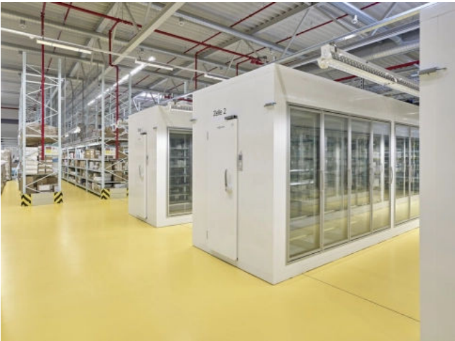
Sanacorp eG, Hürth, DE. System: StoFloor ESD WB 110 – Leitfähiges Beschichtungssystem. Foto: Guido Erbring
