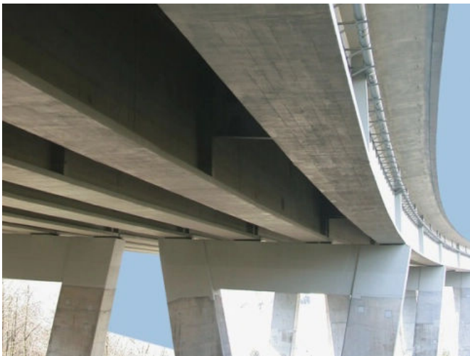
Instandsetzen, verstärken und schützen: Sulzbachtalbrücke, Friedrichsthal / Stegunterseite. Foto: StoCretec
