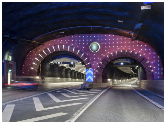
Betonschutzbeschichtung an der Tunneldecke Ärstatunneln, Stockholm, SWE, Swedish Transport Administration. Foto: Mikael Ullén
