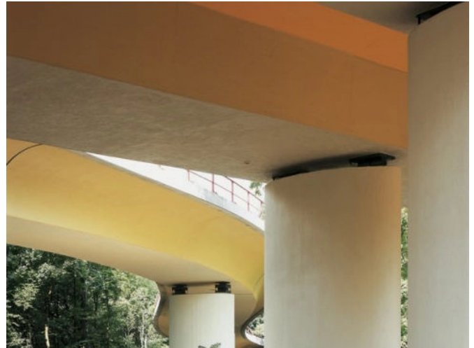
Europaringbrücke Leverkusen, DE. Foto: StoCretec
