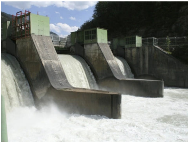
Funktionalität von Wasserbauwerken gewährleisten.
