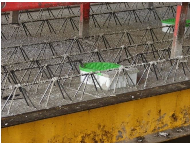
Elektroinstallation in Ortbeton
