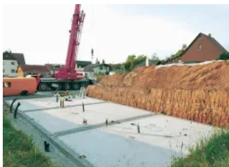
Überprüfung der Bodenplatte. Passen alle BASE-Montagebedingungen geht es los.
