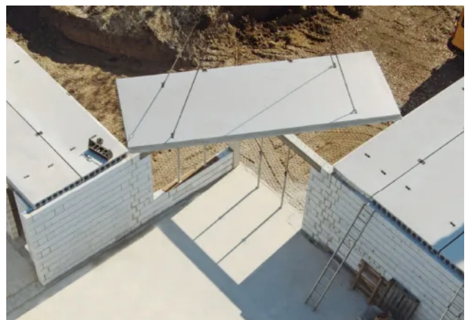
Die im Werk vorgefertigte DX-Decke
