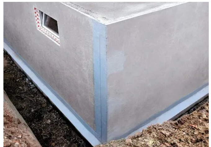
Professionelle Bauwerksabdichtung für den BASE-Fertigkeller
