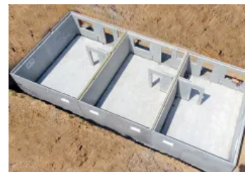
Der BASE-Keller steht. Nun kann sofort mit dem Auflegen der DX-Decke und dem Einheben der Treppe begonnen werden.
