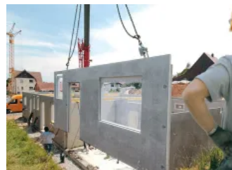
Das letzte vollmassive Wandelement wird platziert. Nahezu alle Kellerwände sind jetzt kraftschlüssig verbunden.
