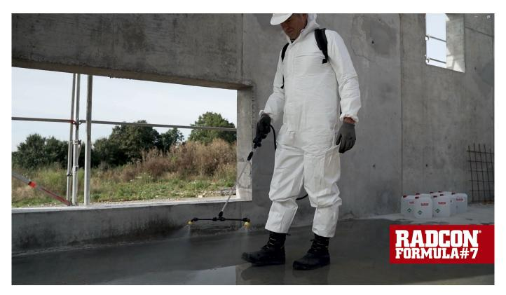
Wasserdichte Oberflächenversiegelung mit Radcon Formula #7®. Diese biochemisch modifizierte Silikatlösung macht den Beton langfristig wasserdicht und haltbar. Sie dringt in den Beton ein und reagiert mit freiem Kalzium und Wasser. Es bildet sich ein nichtwasserlöslicher Calziumsilikathydrat-Gelkomplex in Rissen, Poren und Kapillaren. Dieses Gel bildet eine im Beton integrierte Barriere gegen das Eindringen von Wasser und Verunreinigungen.
