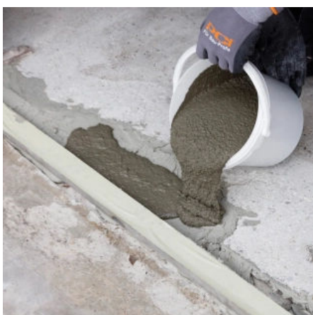
Einfahrtsschiene mit fließfähigem Mörtel hintergießen
