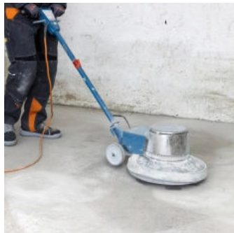
Boden abschleifen
