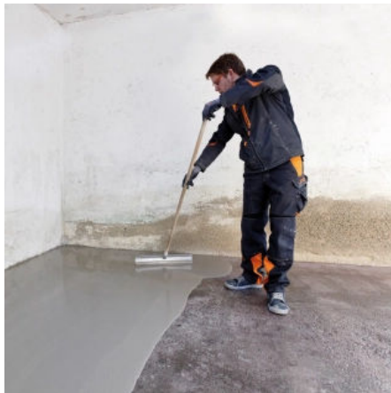
Beschichtung gleichmäßig verteilen
