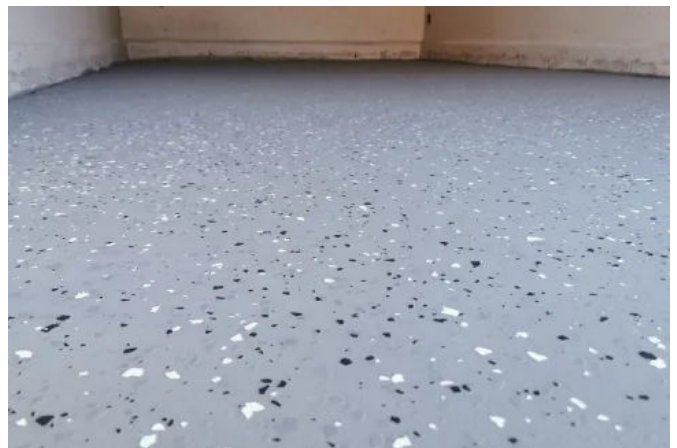
Durch Einstreuen von Farbchips kann die Oberfläche zusätzlich optisch aufgewertet werden.
