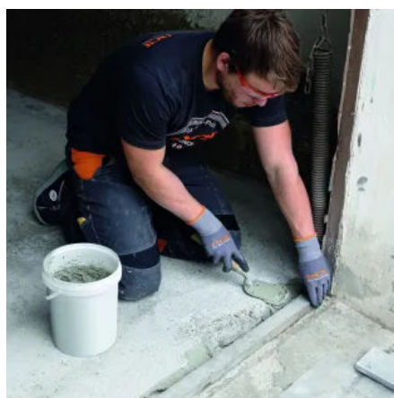
Alternativ Löcher und Ausbrüche mit Mörtel ausspachteln
