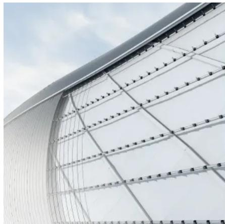
Die **BEMO-DOME** Unterkonstruktion bietet für zylindrische oder über 2-Achsen gekrümmte Gebäudeformen die richtige, weil hoch flexible Unterkonstruktionslösung. Die Bekleidungsmöglichkeiten reichen von metallischen Trapez- und Wellprofilen bis hin zu konischen oder in freier Form verlaufenden BEMO-MONRO Bahnen. Das System zeichnet sich besonders durch gute Tragfähigkeit, Toleranzausgleich und einfache Montage vor Ort aus.
