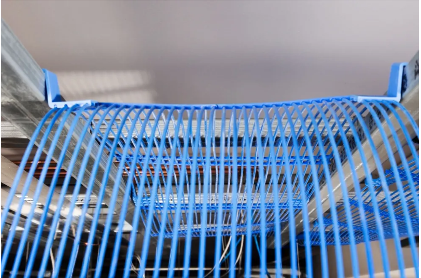
Kapillarrohrmatten Typ K.GK10
