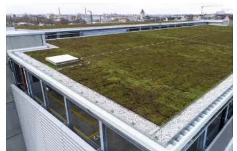
Das Wasserrückhaltevermögen beträgt 20 l/m 2 .
