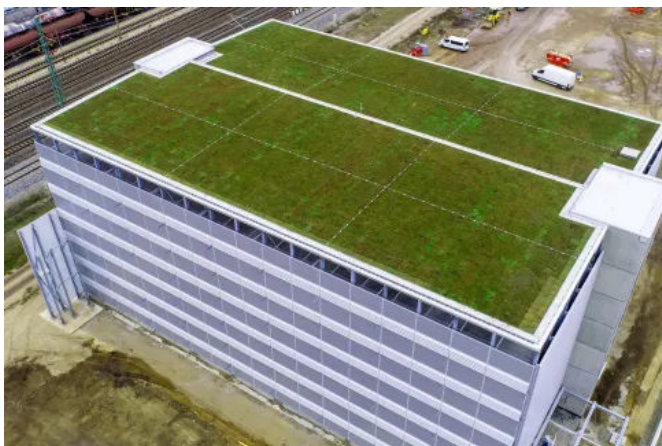
Die Kassetten des Systems bestehen aus recyceltem und wiederverwertbaren Polypropylen (PP).
