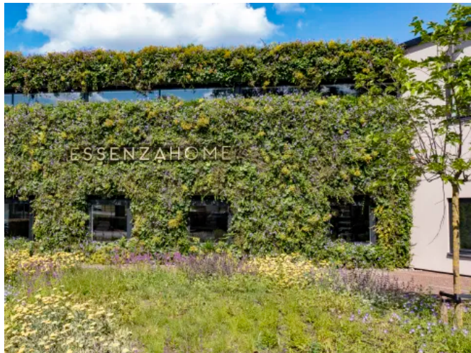
Die MobiPanel Pflanzenwand wird über ein automatisches Bewässerungssystem mit Wasser und Nährstoffen versorgt.
