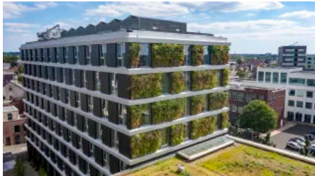
Begrünte Fassaden tragen zur Wärmedämmung eines Gebäudes bei.
