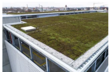
Das Wasserrückhaltevermögen beträgt 20 l/m 2 .
