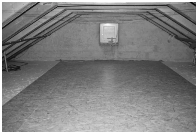
Gedämmter Dachboden mit HIRSCH Porzell Dachbodendämmelement OSB 12 mm
