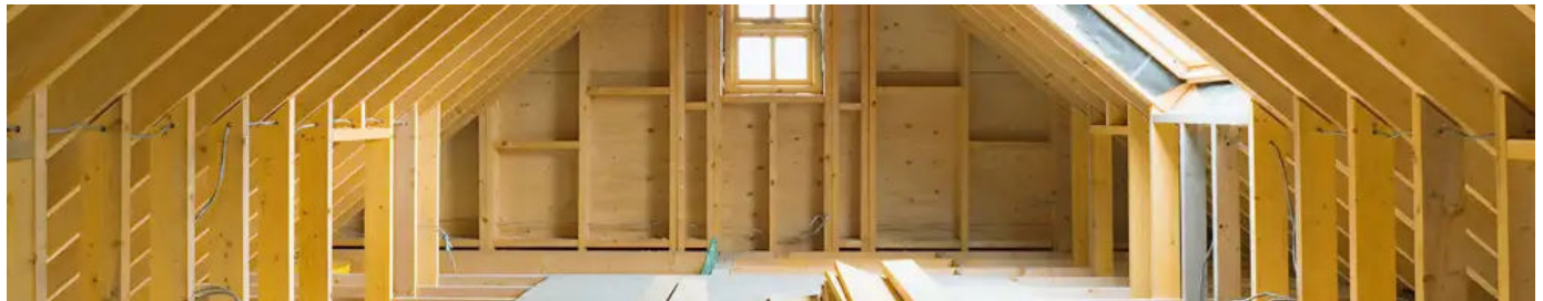
Energetische Sanierung der obersten Geschossdecke mit EPS-Dämmelementen
