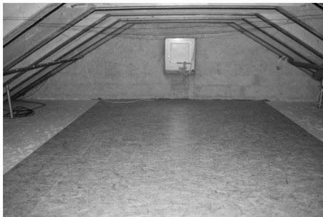
Energetische Sanierung der obersten Geschossdecke mit HIRSCH Porzell Dachbodendämmelement OSB 12 mm
