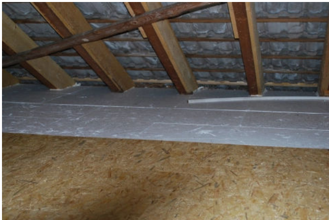
Dachbodendämmung zur Erfüllung der GEG-Anforderungen mit Dachbodendämmelement OSB 12 mm
