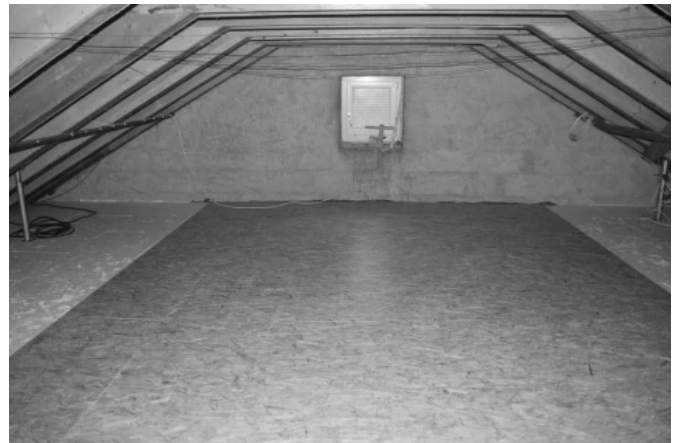
Energetische Sanierung der obersten Geschossdecke mit HIRSCH Porzell Dachbodendämmelement OSB 12 mm
