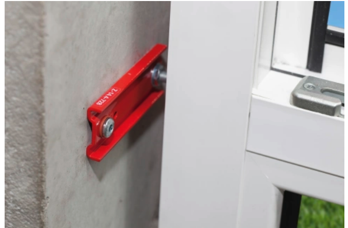
Fenstermontageschiene W-ABZ – Befestigung absturzsichernder Fenster
