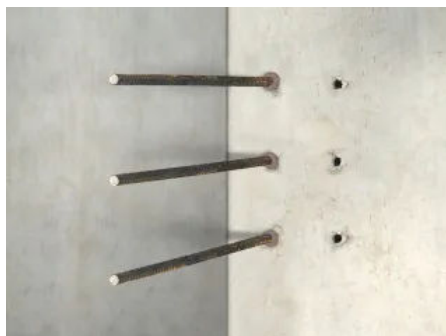
Einsatzbeispiel für nachträgliche Bewehrungsanschlüsse
