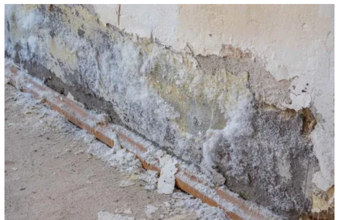
Die Untergrundvorbereitung und Behandlung bauschädlicher Salze bildet die Grundlage für eine nachhaltig funktionierenden Sanierung.
