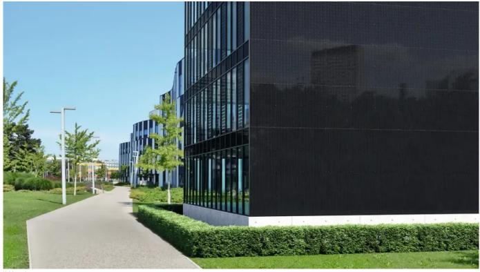
In hinterlüfteten Fassadensystemen können BIPV-Module als äußere Bekleidung eingesetzt werden. Sie übernehmen dabei sowohl den Schutz vor Witterungseinflüssen als auch gestalterische Aufgaben.
