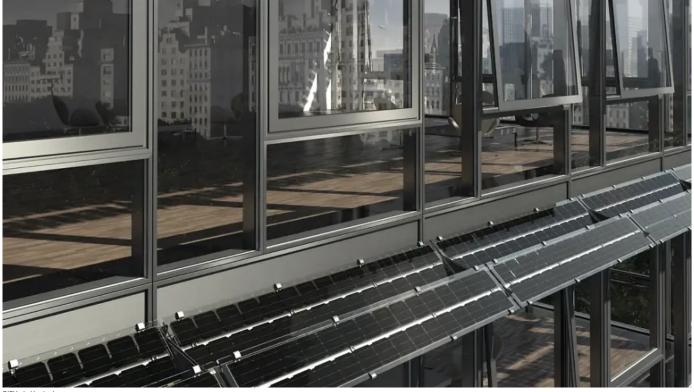
Ob Fenster, Eingangsbereiche oder Terrassen: Lamellen, Schiebeläden oder Vordächer beiten in Verbindung mit den Photovoltaikmodulen kreative Lösungen, um individuelle Architektur zu gestalten - und gleichzeitig Schutz vor Sonneneinstrahlung und Niederschlag zu bieten.
