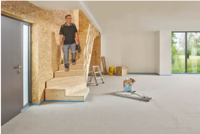
Bautreppe Vario während der Bauphase (© studio 3001)
