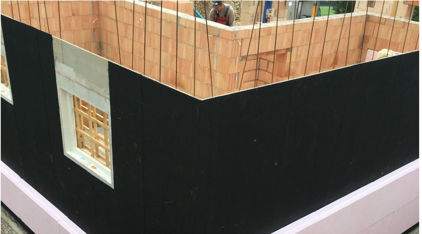
Sichere Abdichtung erdberührter Bauteile nach DIN 18533 mit RESITRIX® EPDM-Abdichtungsbahnen.
