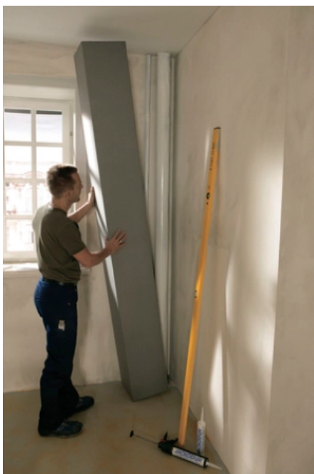
Rohrverkleidung mit JACKOBOARD® Canto
