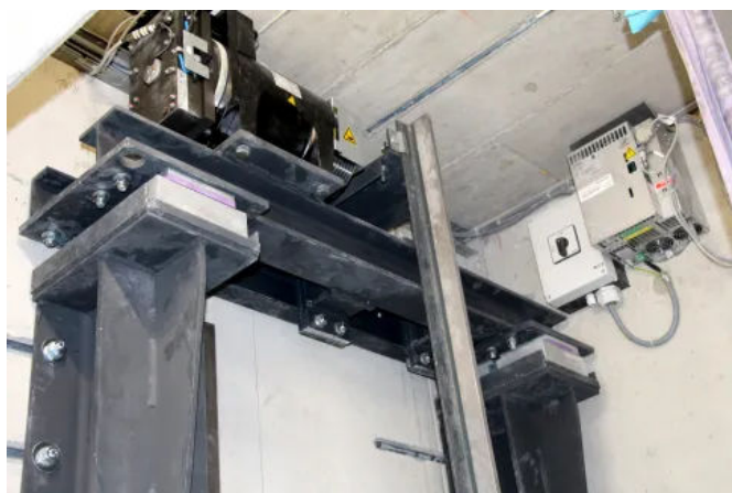
Lagerung einer Aufzuganlage mit Isotop SE-DE
