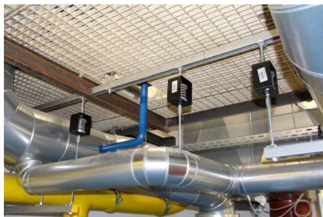
Entkoppelung von Rohre mit Isotop SD Z
