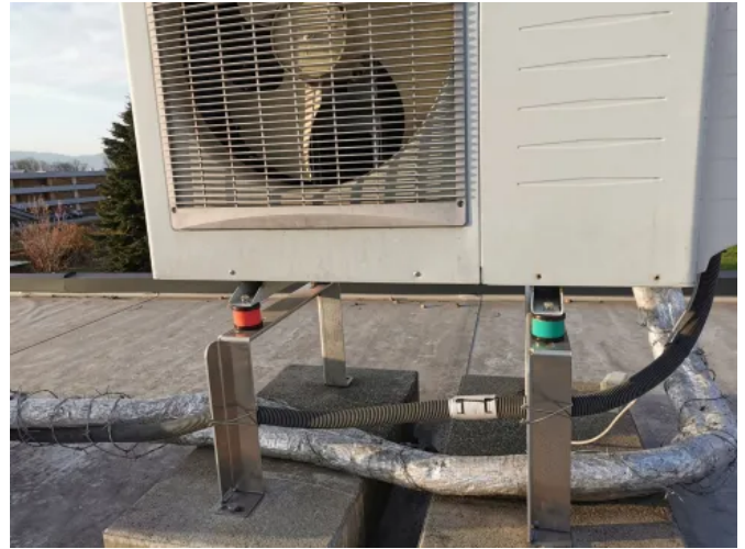
Lagerung einer Wärmepumpe mit MSN-DAMP
