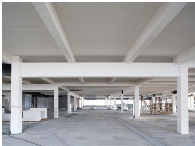
Sanierung Verwaltungsgebäude der Deutschen Rentenversicherung, Berlin (PROMATECT®-H)
