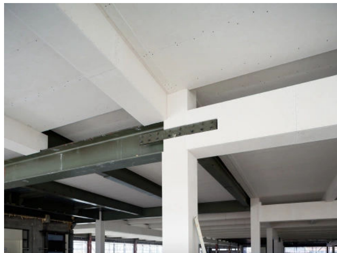
Sanierung Verwaltungsgebäude der Deutschen Rentenversicherung, Berlin (PROMATECT®-H)
