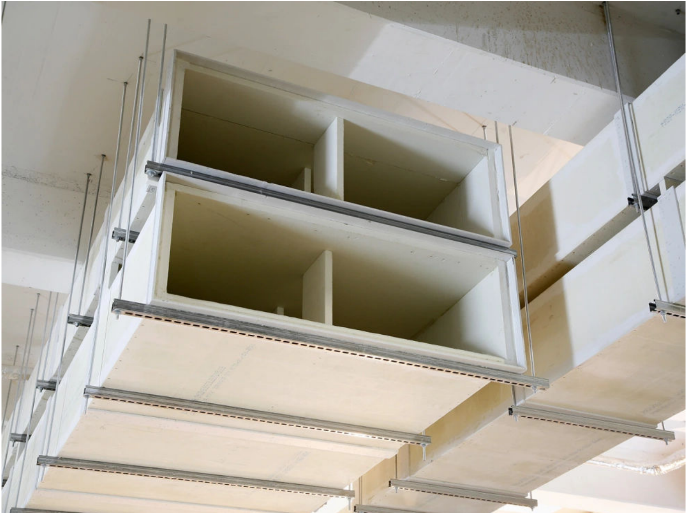
PROMATECT®-LS-Lüftungsleitungen, Köln
