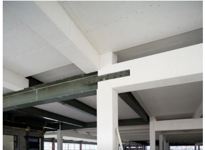
Sanierung Verwaltungsgebäude der Deutschen Rentenversicherung, Berlin (PROMATECT®-H)
