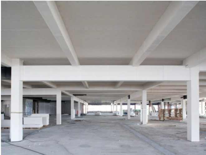
Sanierung Verwaltungsgebäude der Deutschen Rentenversicherung, Berlin (PROMATECT®-H)
