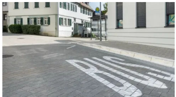
GDM.BUSBORDE sind speziell auf Niederflrbusse ausgelegt
