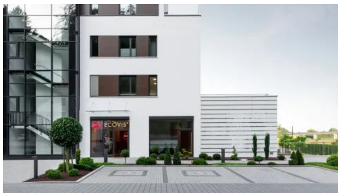
Rollstuhlgerechter Parkplatz im öffentlichen Verkehrsraum
