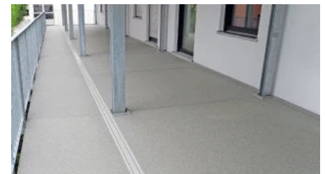
Detail mittlere Entwässerungsrinne
