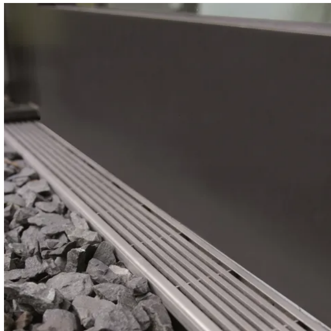
BLANKE BALKON-LINE eingebaut
