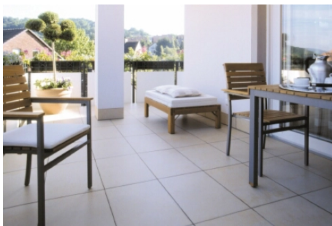
Auch dieser Balkon wurde mit Schlüter®-DITRA saniert.
