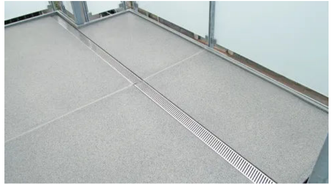
Detail Bakodur® E Holzzement-Gefälleplatten mit Ablaufrinne
