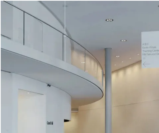
Anwendungsbeispiel gebogene Ganzglasbrüstung im Innenbereich
