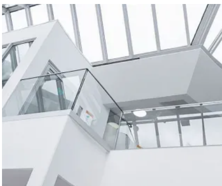
Anwendungsbeispiel Ganzglasbrüstung mit Edelstahl-Kantenschutzprofil
