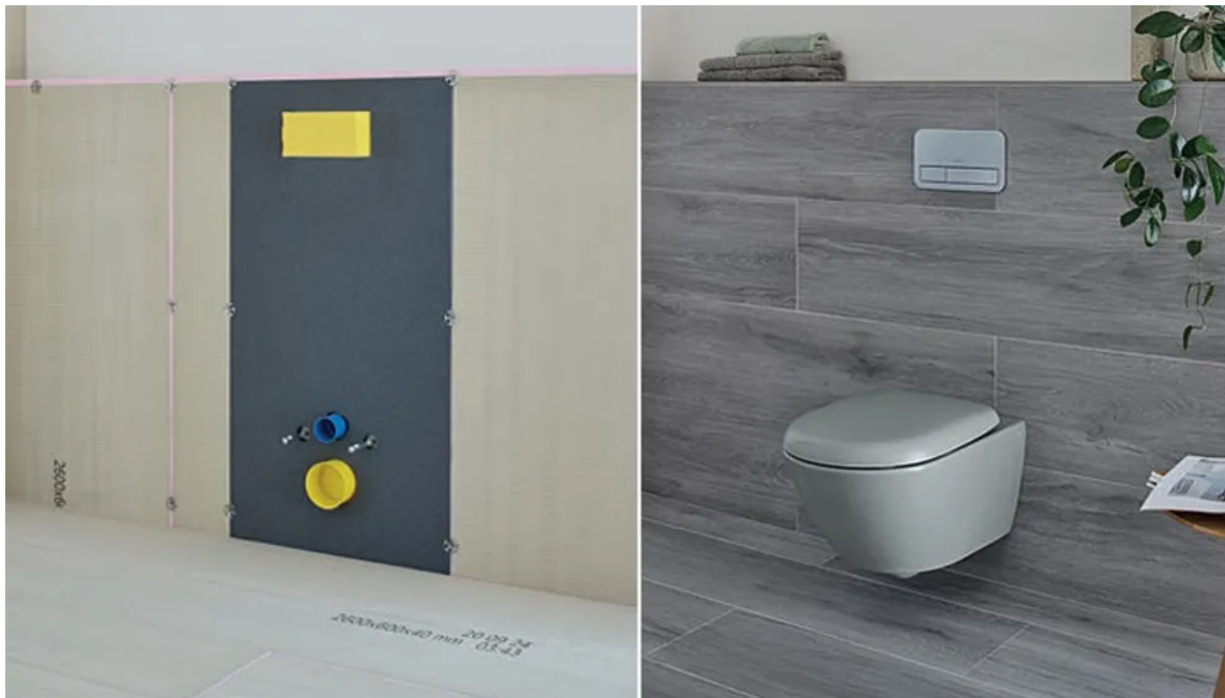
Einbausituation WC-Board vor und nach dem Fliesen der Wände
