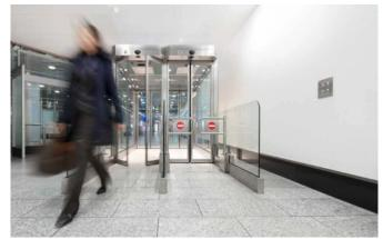
Ausführung TWIN ist die Variante mit dem höchsten Sicherheitsniveau. Infrarot-Sensoren mit Volumenüberwachung erfassen den Bereich vor und nach den Pforten und scannen den Innenraum kontinuierlich nach an Boden, Decke und Wänden befestigten Gegenständen. Auch Durchwurfversuche werden zuverlässig erkannt.
