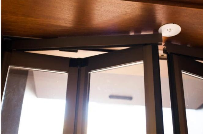
Record FTA 20 FBO mit mechanischer «Break-out»-Funktion (FBO)
