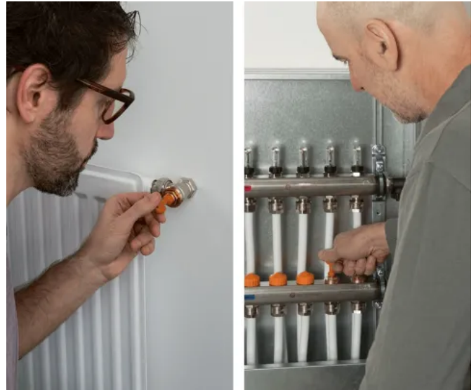
Ob am Heizkörper oder an der Fußbodenheizung: Der erforderliche Durchfluss wird direkt am Eclipse Ventil eingestellt.
