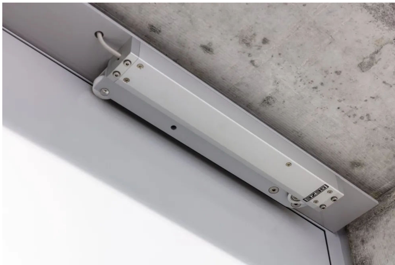
RWA K 600 T – Klapphebelantrieb für Zuluftsysteme zur Montage an Türen, © GEZE GmbH / Lorenz Frey
