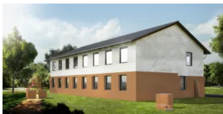
Während der Bauphase
