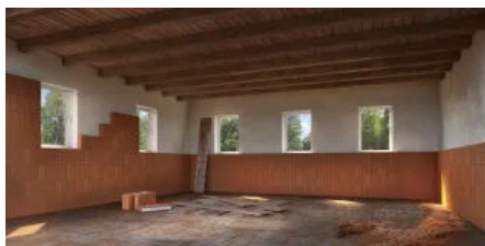
Während der Bauphase
