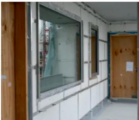
Die Befestigung der Fassadenkonstruktion erfolgt durch punktförmige Stabanker, diese durchdringen die Elemente in den Paneel-Stoßfugen. Möglich sind hochwärmedämmende Systemaufbauten mit ca. 100 mm. Die seitlichen Anschlüsse an die begrenzenden Bauteile werden mit einem systemkonformen Dämmstreifen versehen.
