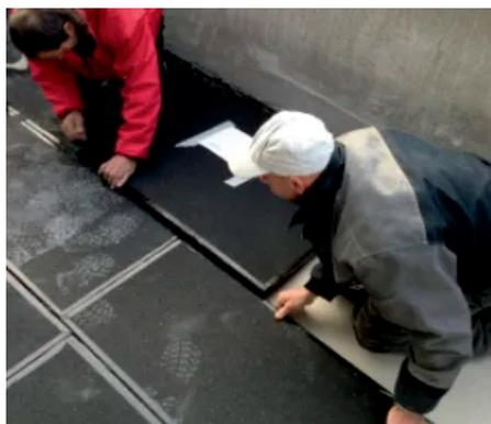
Das VIP-Element ist QASA-D-VT-A-DA-2 R-GGR für die Einsatzbereiche als Balkon-, Terrassen- und Flachdachdämmung geeignet. Durch die mit dem VIP-Panel kraftschlüssig verbundenen Gummipplatten-Deckschichten wird eine beidseitig geschützte Oberfläche erreicht.
