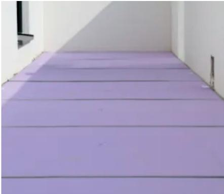
Das VIP-Bauteil QASA-D-VT-A-DA-2-XPS ist als Flächendämmung im Außen- und Innenbereich geeignet. Im Außenbereich unter anderen für die Einsatzbereiche als Balkon-, Terrassen- und Flachdachdämmung und im Innenbereich als Bodeninnendämmung.
