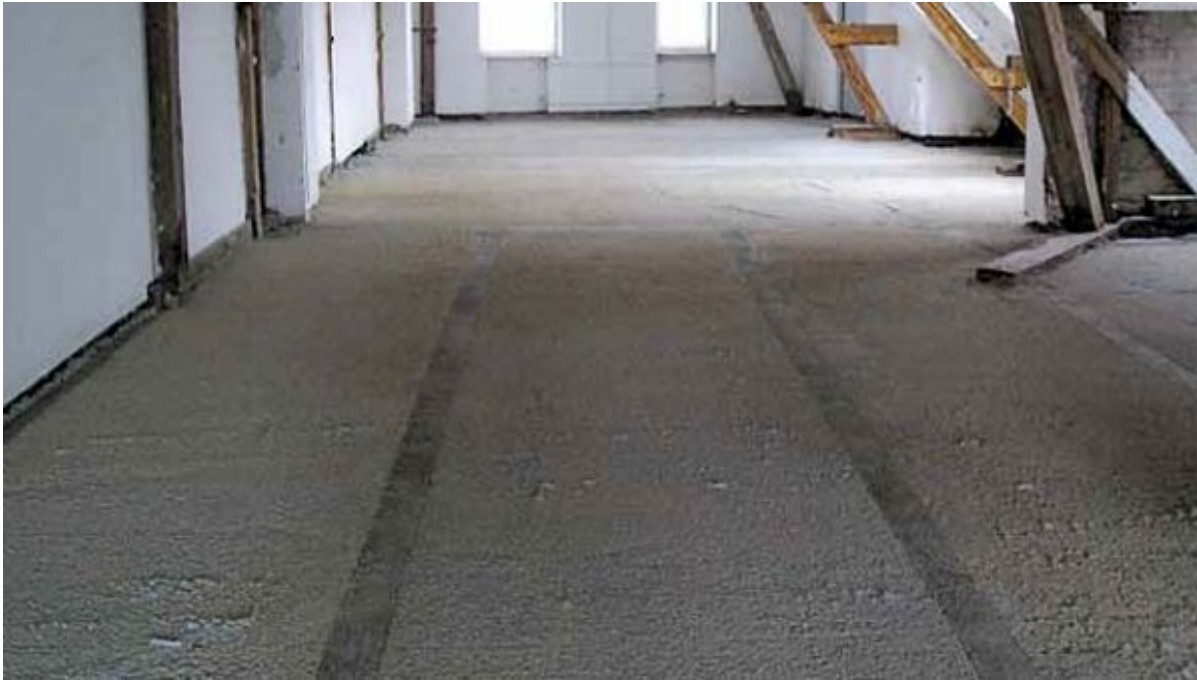
Leichtausgleichsmasse auf Basis Zement-Styropor
