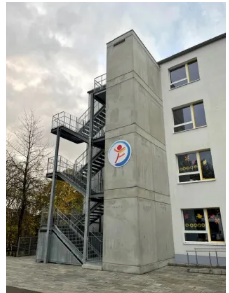
Aufzugsschacht an einer integrativen Schule in Lauingen
