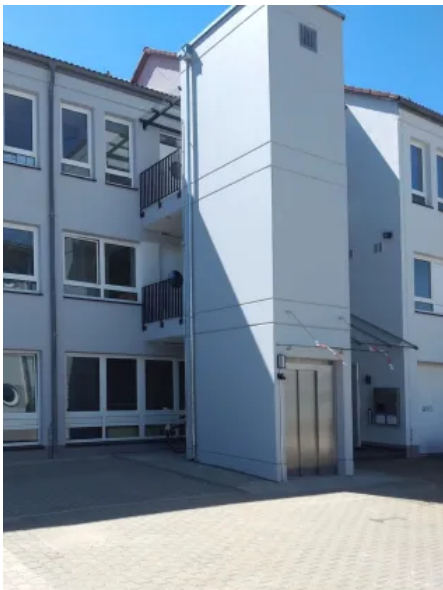
Aufzugsschacht an Verwaltungsgebäude in Friedberg
