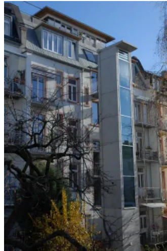
Wohnhaus mit Aufzug in Frankfurt
