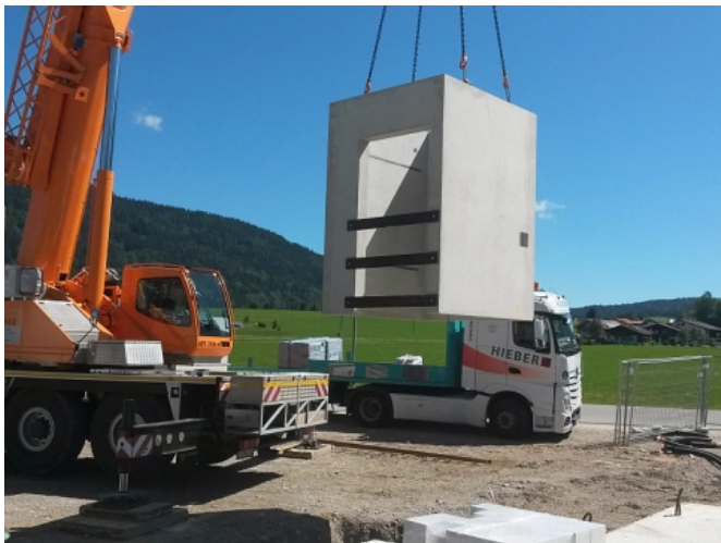
Die geschosshohen Elemente werden Just-in-Time angeliefert.
