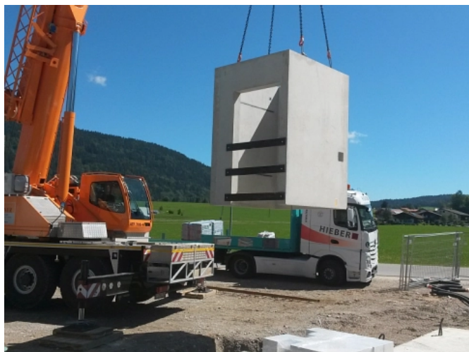
Die geschosshohen Elemente werden Just-in-Time angeliefert.
