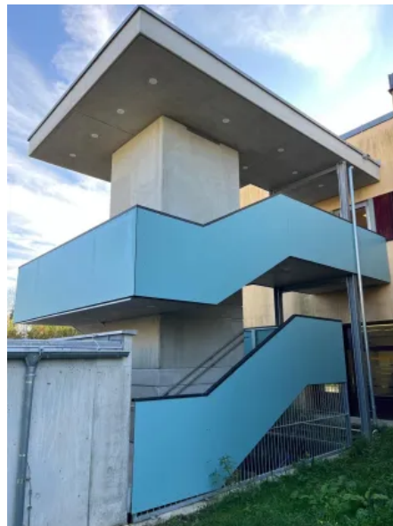
Kombination Aufzugsschacht mit Treppenaufgang in Fürstenfeldbruck
