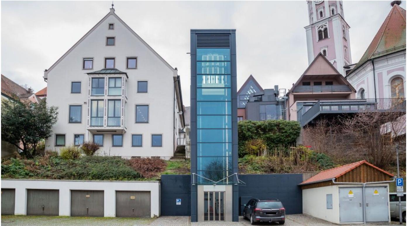
Vorgefertigte Betonelemente ermöglichen den schnellen und rationellen Bau von Aufzugsschächten. HIEBER® Aufzugsschachtelemente werden in Abstimmung mit dem Aufzugsbauer geplant, werkseitig nach Kundenwunsch ausgestattet und Just-in-Time auf die Baustelle geliefert.
