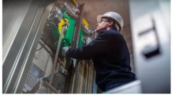
Der regenerative KONE EcoDisc®-Antrieb gewinnt bis zu 40% Energie als nutzbaren Strom zurück und nutzt sie für die Beleuchtung und andere Zwecke.
