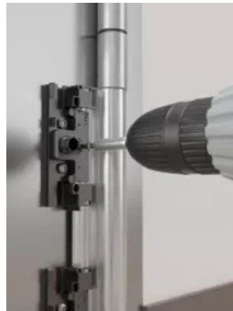
Anschrauben mit passenden Bohrschrauben ohne Vorbohren und Senken
