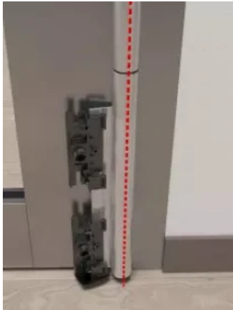
Ausrichten in der Flucht des Bandes und Andrücken der Profile mit Klebepads
